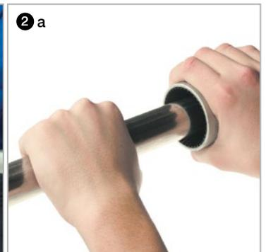
3. Markierung der erforderlichen Einschubtiefe des Rohrs in den Fitting - notwendig für korrekte Festigkeit der Verbindung.
