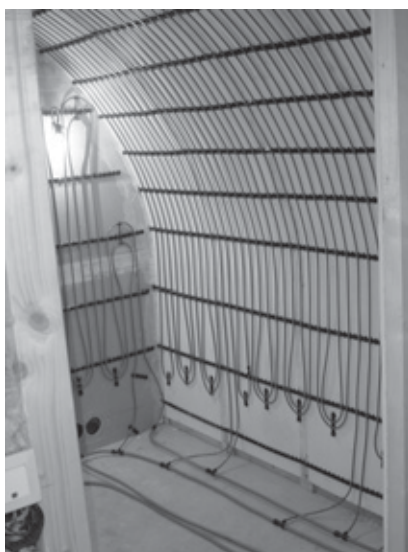
Abb.3 Wandheizsystem für Nassverlegung
