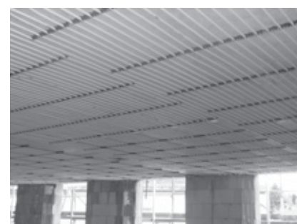
Abb.4: Deckenheiz/-kühlsystem in der Putzschicht integriert
