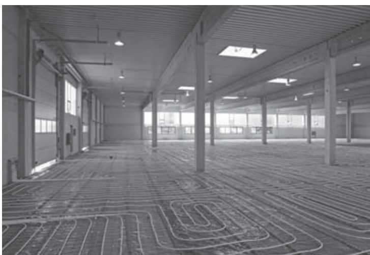
Bild 2: Betonkonstruktion mit Mattenbewehrung
