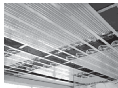
Abb.5 abgehängtes Deckenheiz/-kühlsystem
