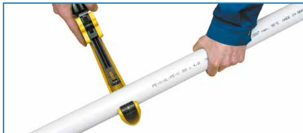
Das Rohr mit dem Rohrschneider senkrecht ablängen.
