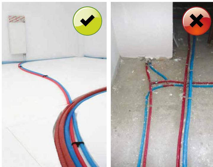
Die Einhaltung dieser Regel ist besonders wichtig, wenn ein Schrumpfen der Rohrleitung möglich ist (z. B. bei einer Installation mit kaltem Wasser im heißen Sommer). Wenn ein langer Abschnitt der Rohrleitung gerade verläuft, ohne Knicke oder Biegungen, besteht die Gefahr, dass das Rohr aus der Verbindung herausgezogen wird, z. B. aus dem T-Stück.
