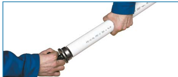
Das Rohr mit dem Kalibrier-Fasenschneider entgraten und kalibrieren.
