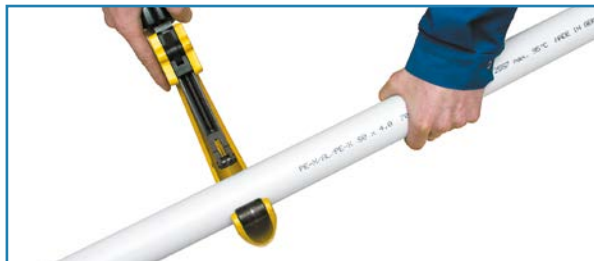
Das Rohr mit dem Rohrschneider senkrecht ablängen.
