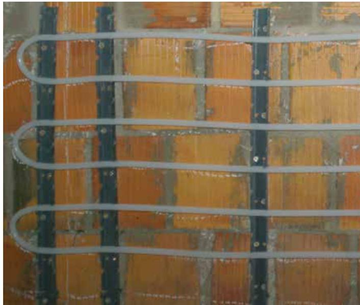
Die KAN-therm Wandflächentemperierung (Heizen und Kühlen) bietet ganz neue Möglichkeiten der Raumgestaltung und lässt sich an jede Art von Wand montieren. Gerade auch im Badbereich ist durch warme Wandfliesen ein erhöhter Komfort gegeben.
