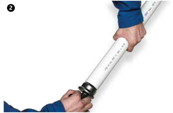
Das Rohr mit dem Kalibrier-Fasenschneider entgraten und kalibrieren.
