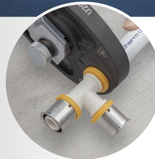
05 Fachgerechte Ausführung der Pressverbindung
